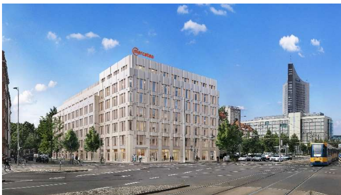
Die Bauarbeiten für die Mercateo Unternehmenszentrale haben begonnen. [Foto: OFB Projektentwicklung / Lindenkreuz Eggert]
